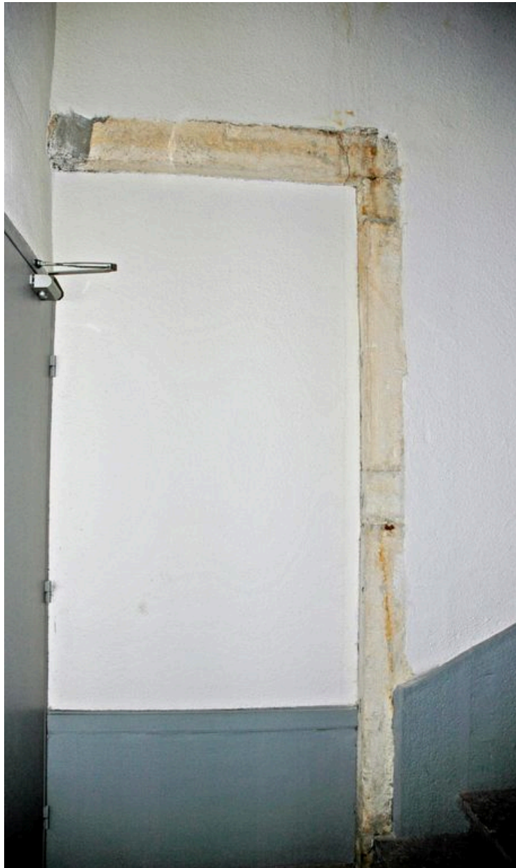
Détail d'une ancienne porte murée au niveau du 1er étage
