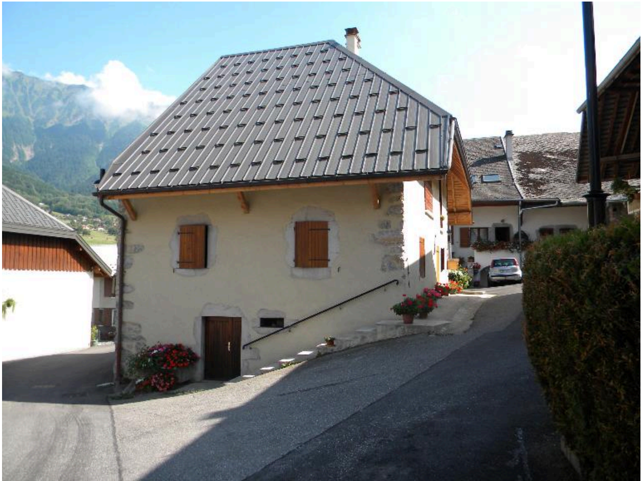
Vue de la façade nord d'une maison (2008 F7 881)
