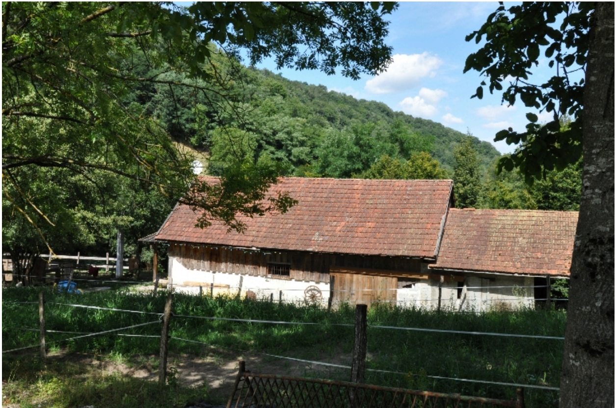
Vue générale de l'ancienne scierie, façade sud-ouest
