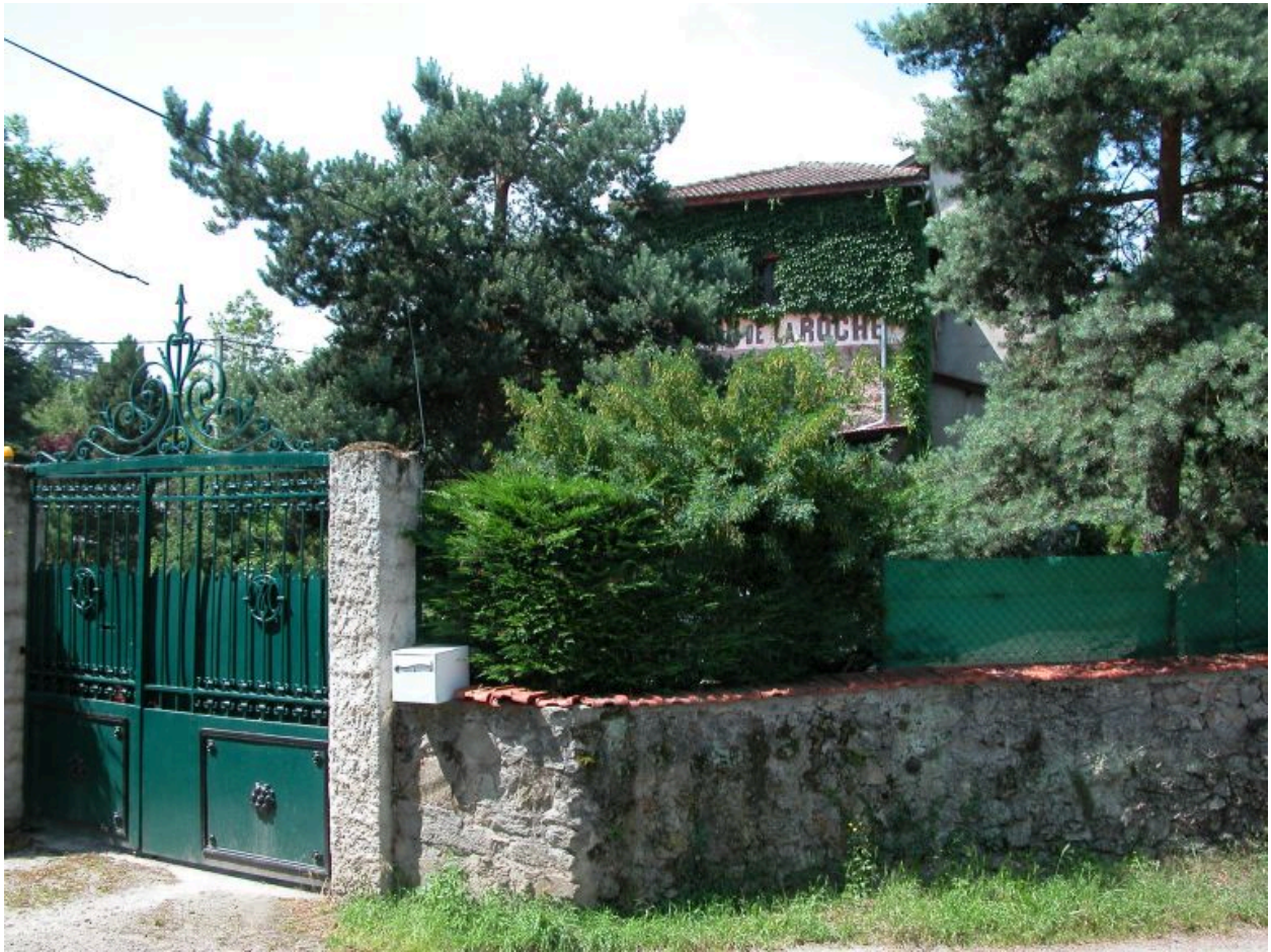
Portail d'entrée du moulin dit de la Roche
