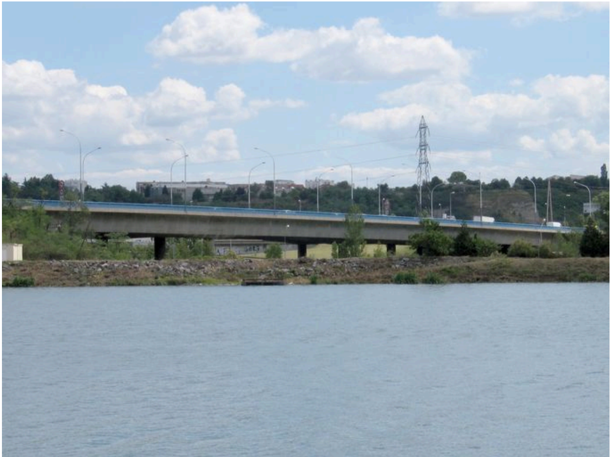
Vue générale, face aval (depuis la rive droite du bras droit du Rhône)
