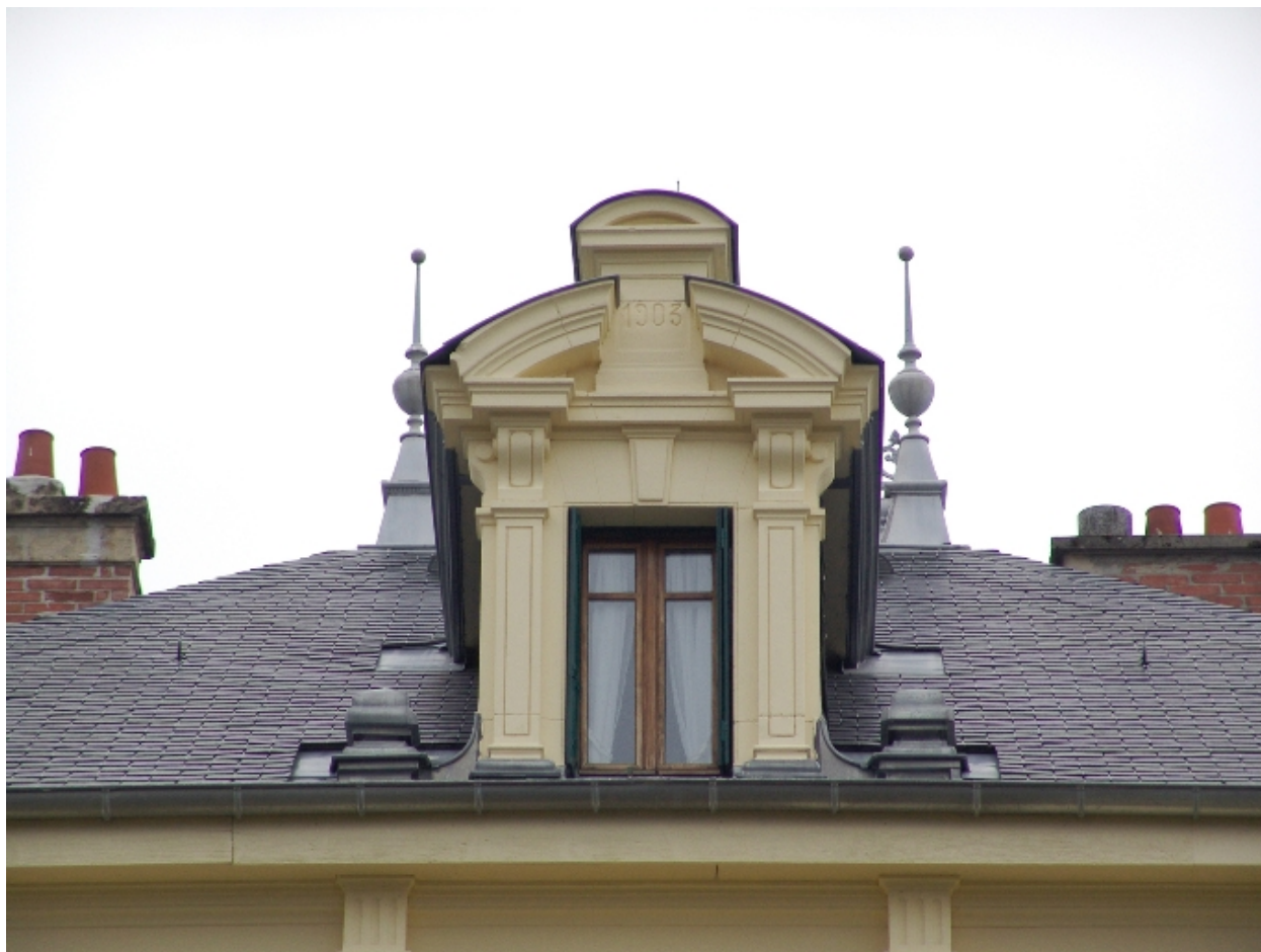
Détail d'une lucarne
