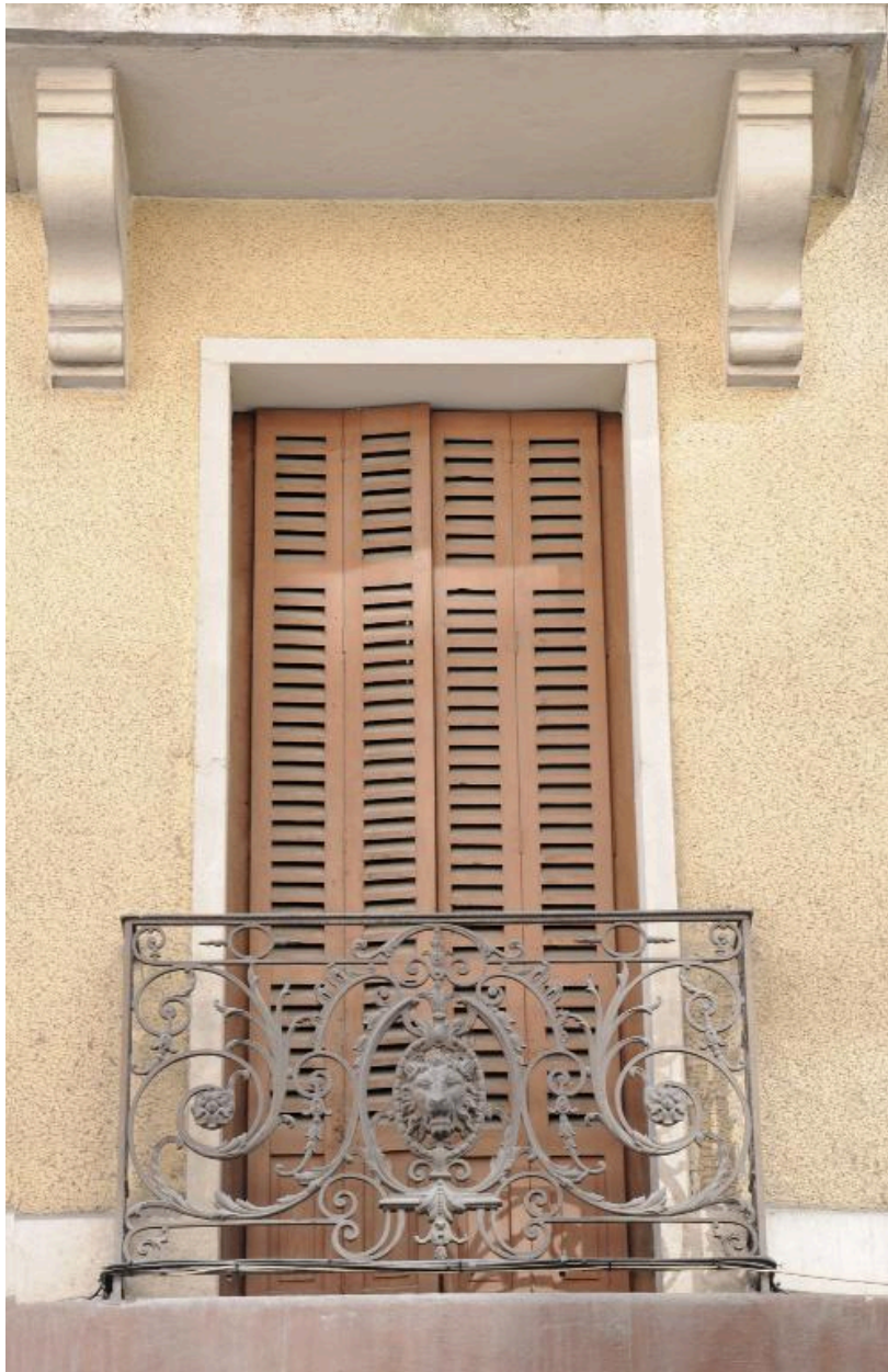
Baie et balconnet au 1er étage
