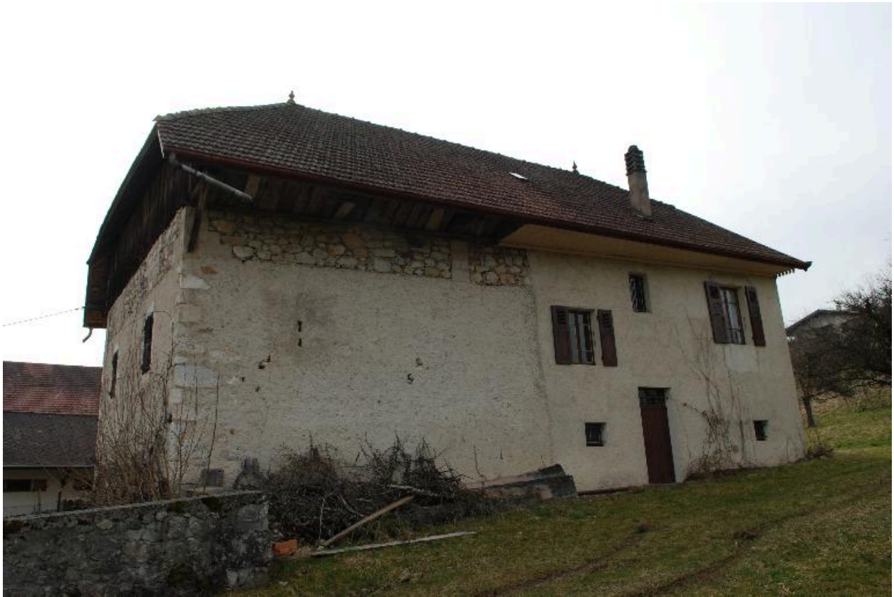
Vue d'ensemble de la façade arrière
