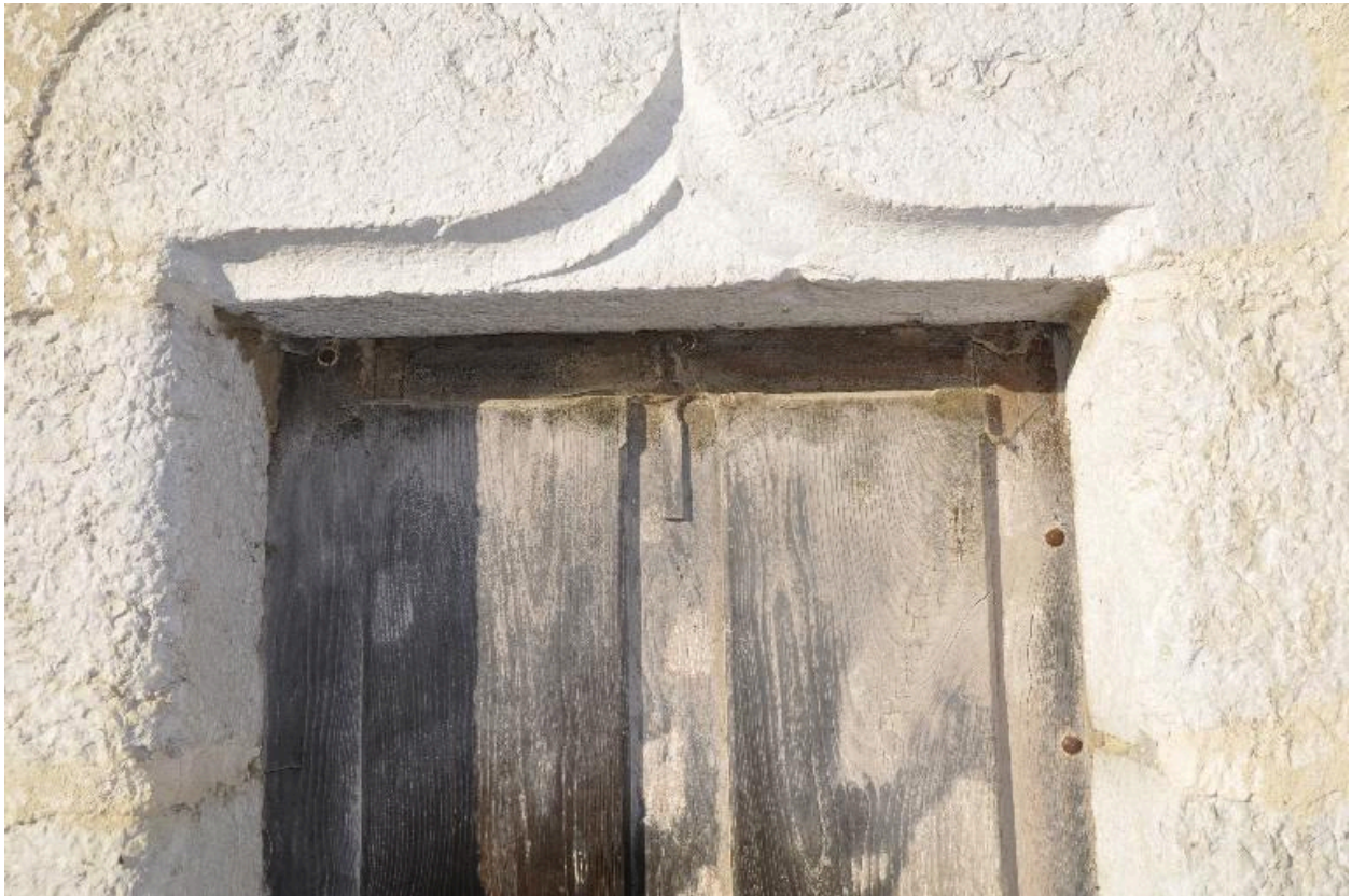
Logis 1, détail du linteau en accolade de la porte.
