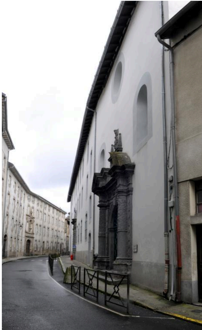
Façade, vue depuis le sud
