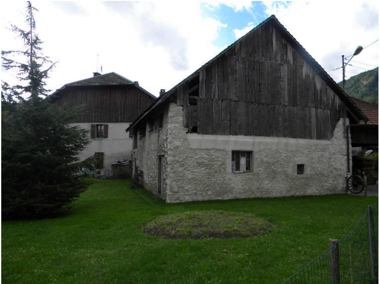
Vue de trois-quarts depuis le nord-est
