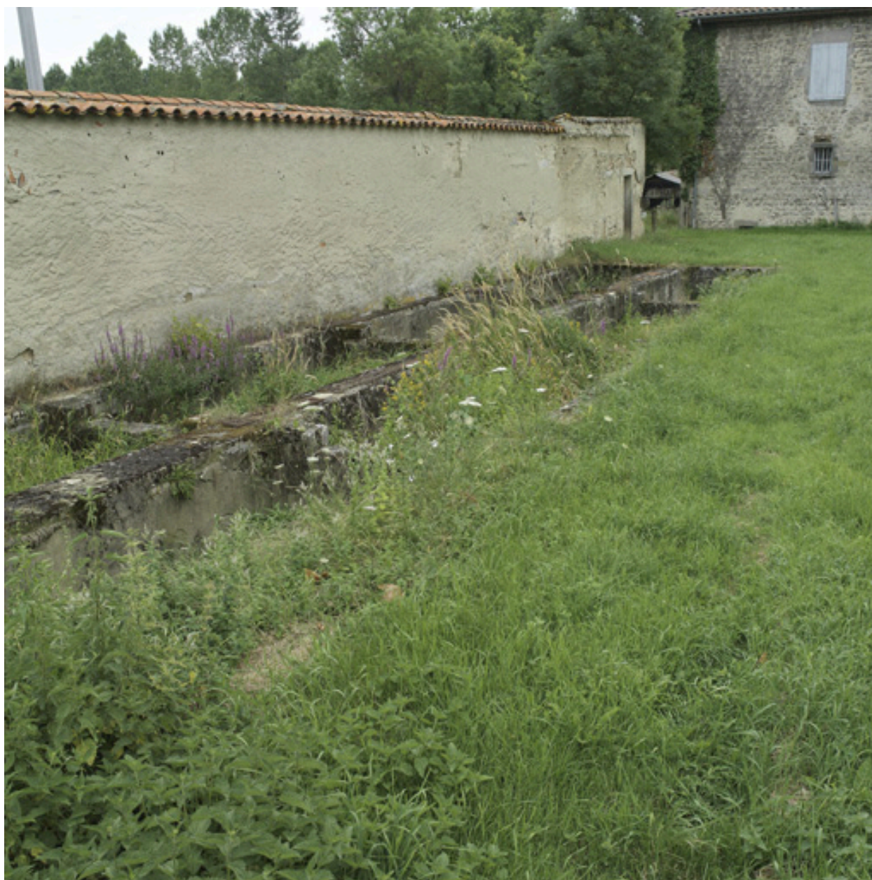
Vue d'ensemble des serves.
