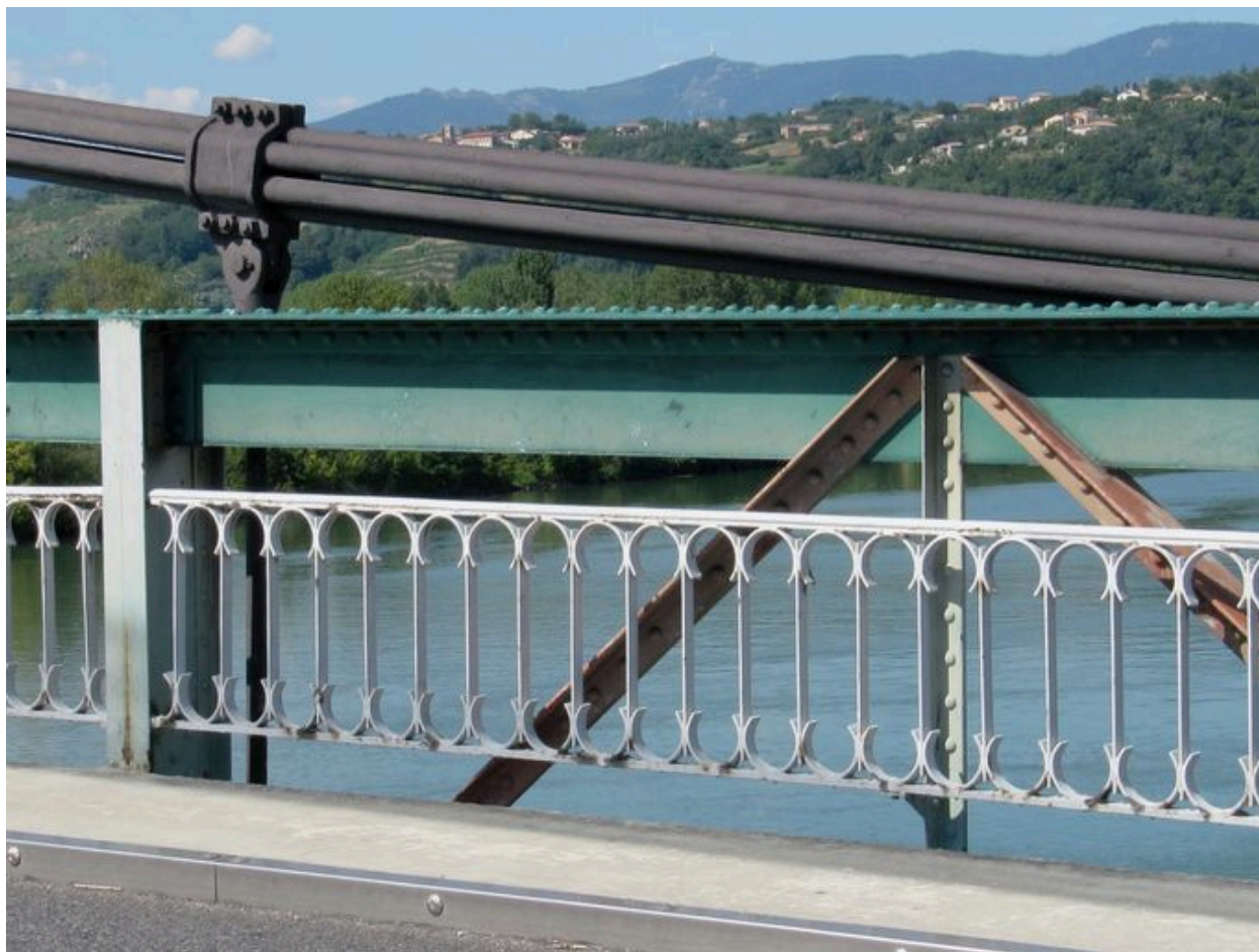
Garde-corps, vue partielle
