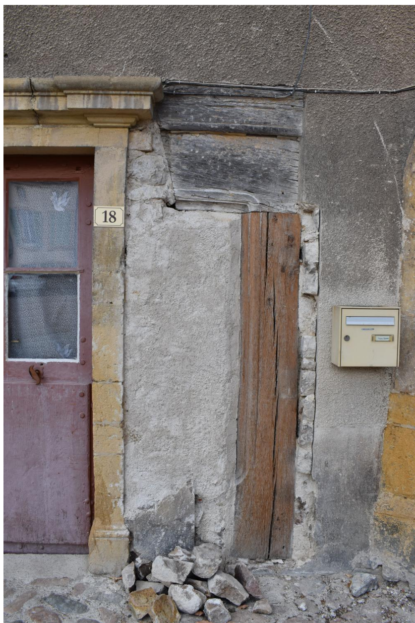
Elévation est de la maison, détail du linteau bois du rez-de-chaussée.
