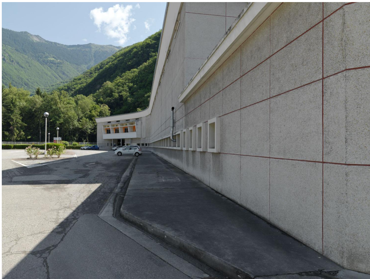
Détail façade principale du bâtiment extérieur de la centrale
