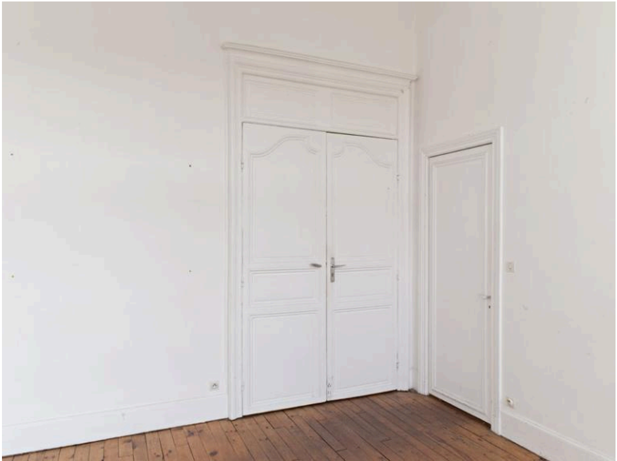
Hôtel-Dieu de Clermont-Ferrand. L'hôtel-Dieu, corps de bâtiment nord, premier étage, porte du bureau de direction.
