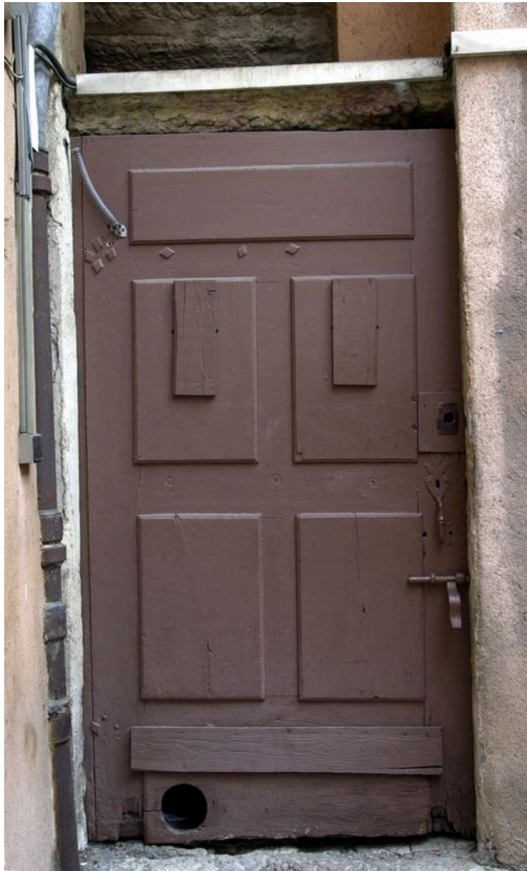
Porte de la cour vers le vestibule
