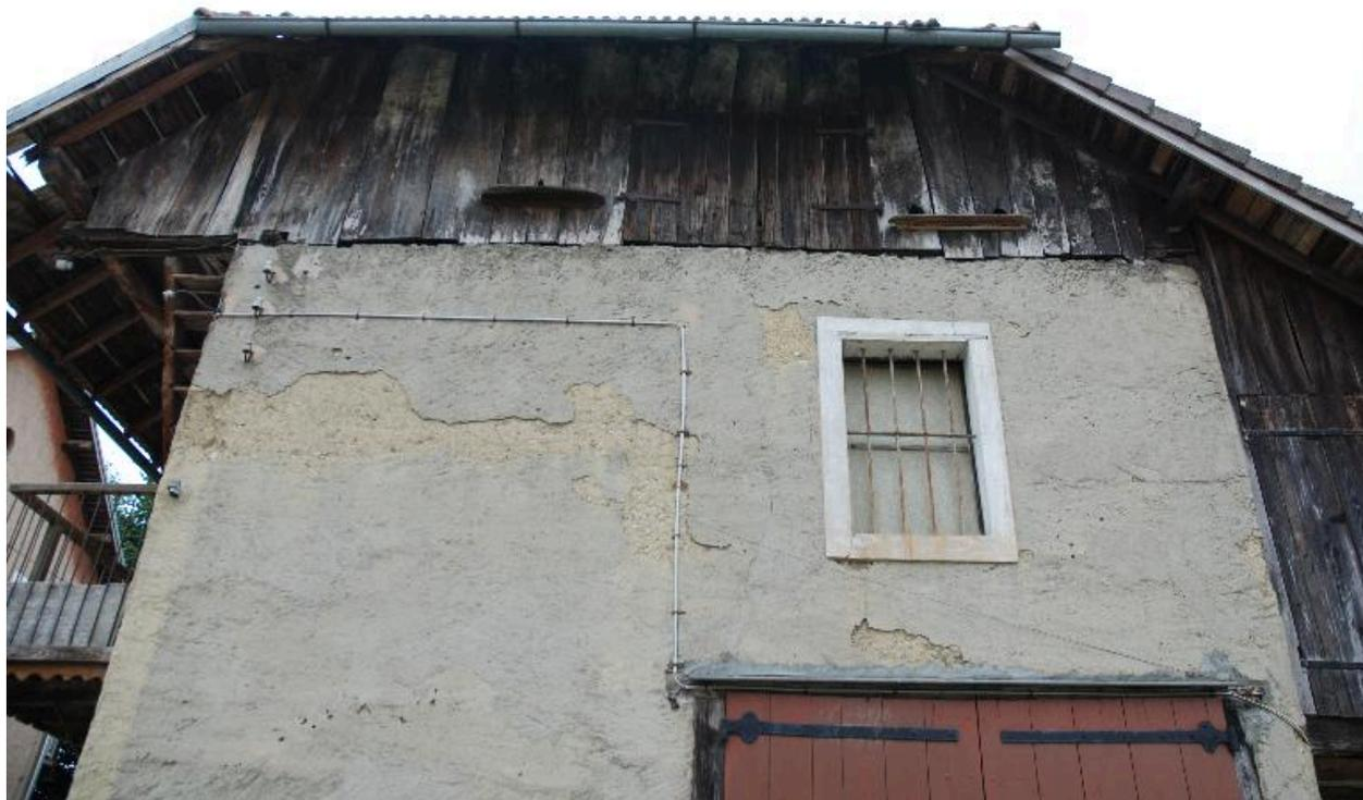
Pignon est du bâtiment nord : détail des matériaux (mur en pisé, enduit terre avec plate-bande peinte sur l'angle et autour de la fenêtre, pignon en planches de bois avec trous et planche d'envol pour des pigeons).
