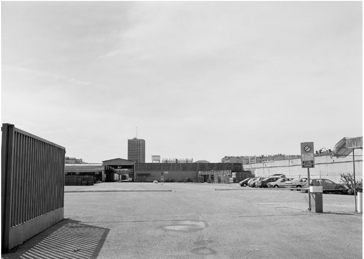
Entrée Lacassagne, vue nord
