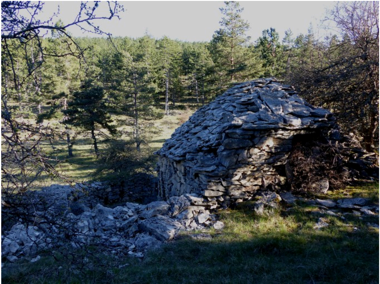
Cabane nord. Vue d'ensemble prise du nord-ouest.
