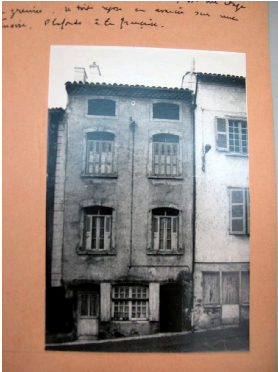
Façade, photographie de Louis Bernard en 1976. photographie de 1976 AD Loire. 1111 VT 128
