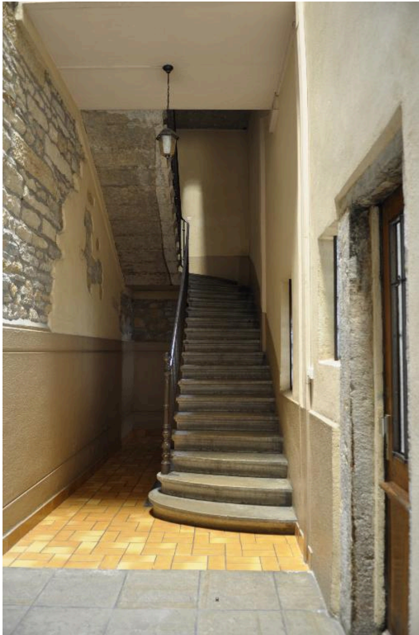
Départ de l'escalier à cage ouverte, dans la cour
