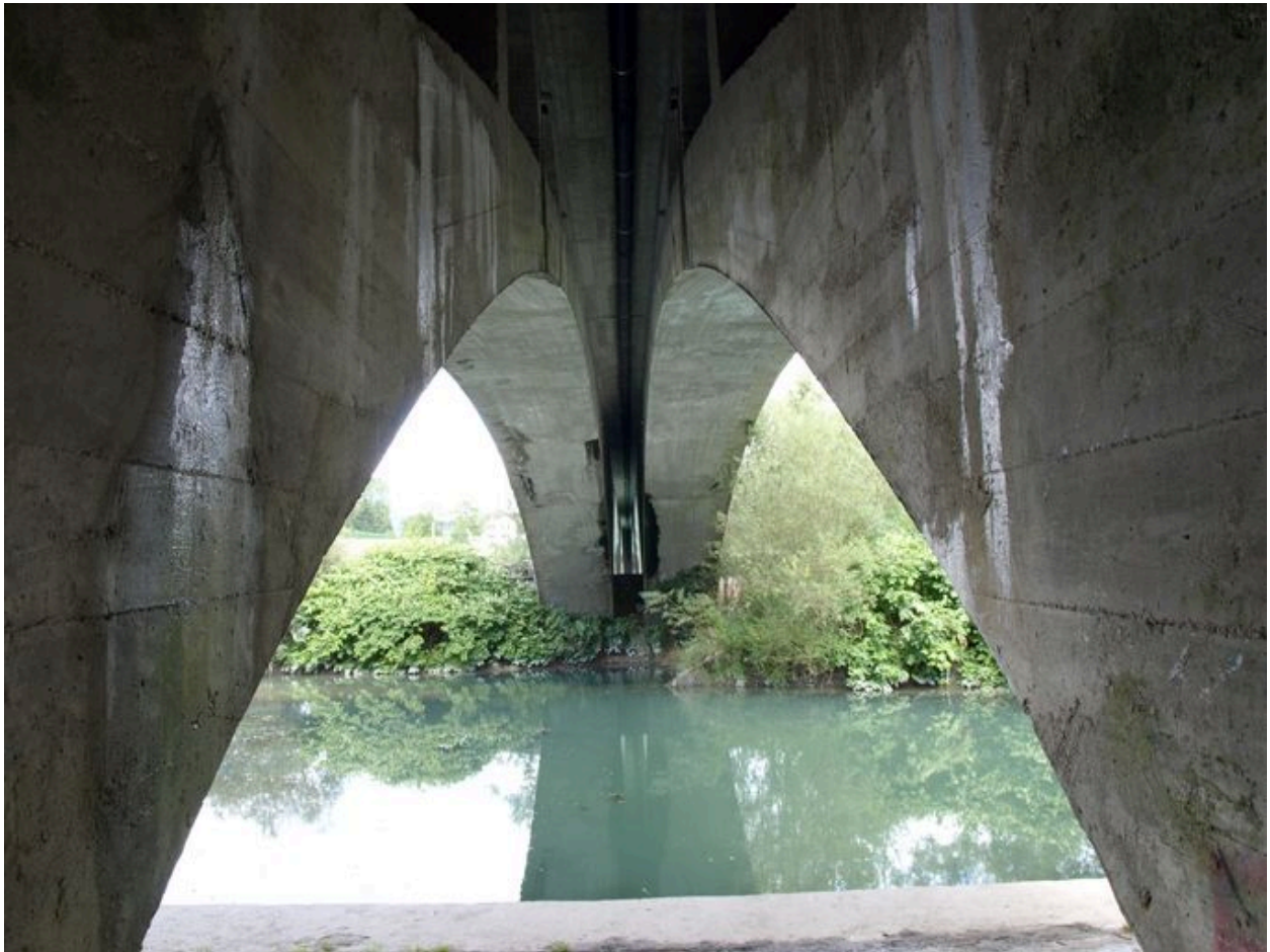
Tablier vu de dessous (depuis la rive gauche)
