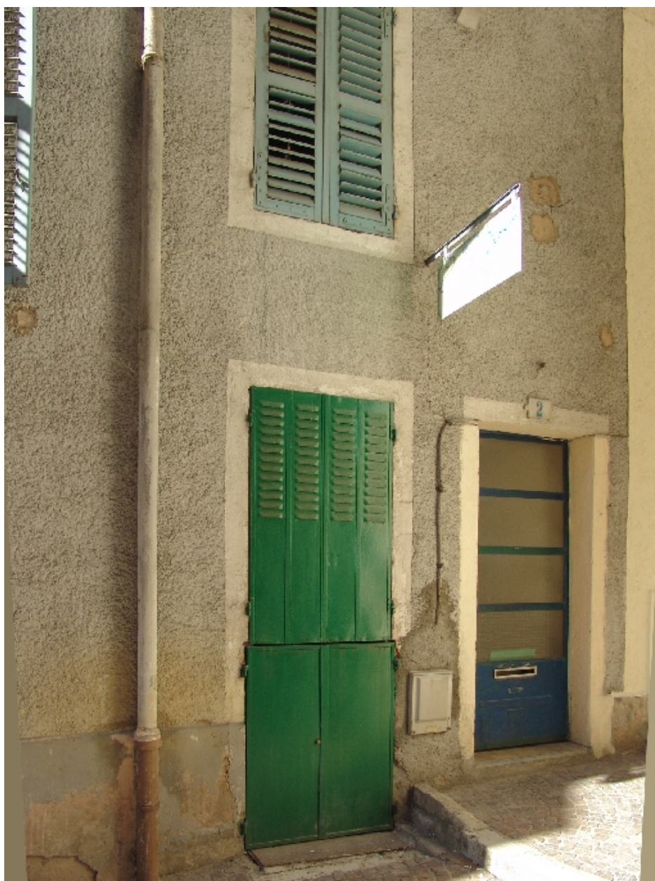
Vue partielle de la façade
