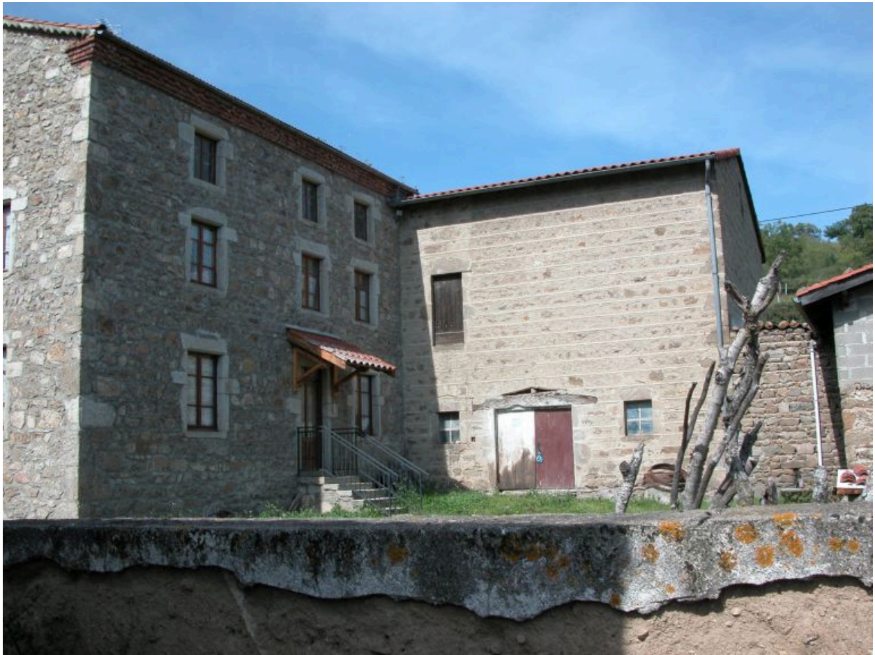
Vue d'ensemble des façades de la ferme sur cour.
