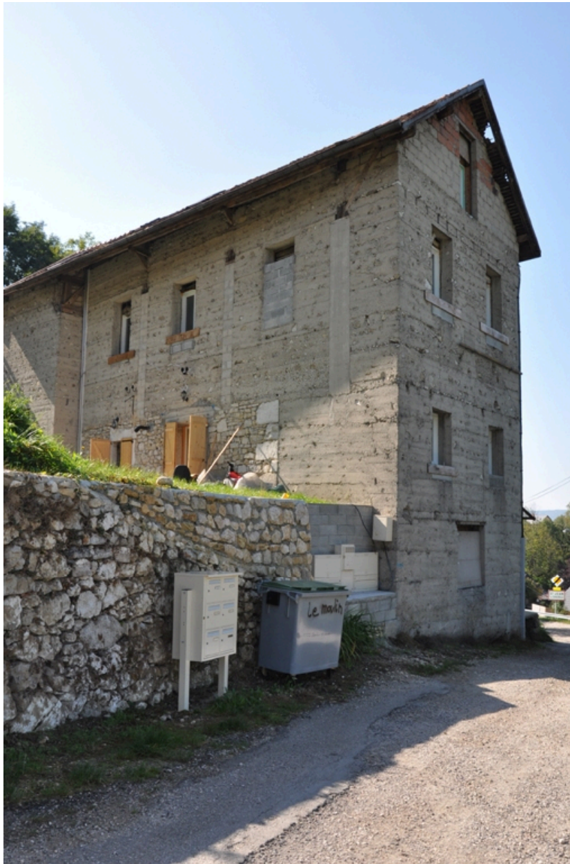
Vue des façades est et nord
