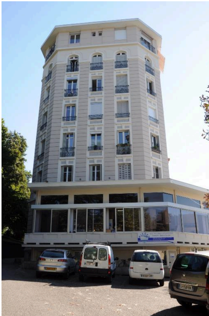
Façade latérale gauche (nord)
