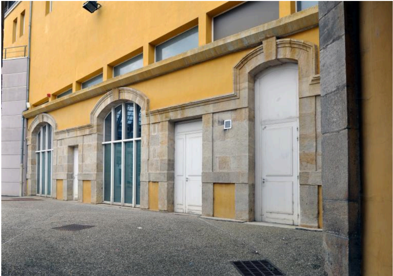
Bâtiment H : détail de l'élévation sur cour 1
