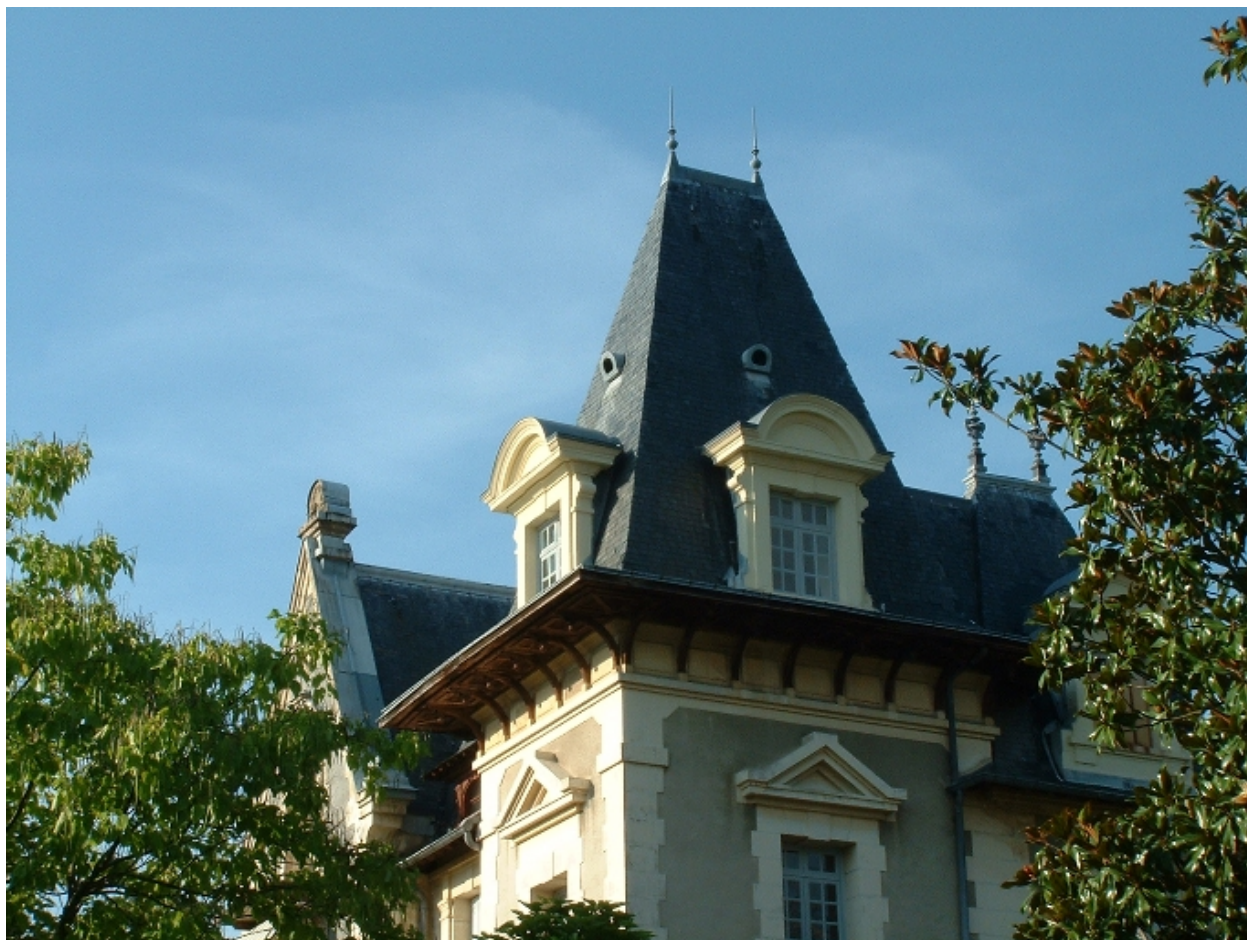
Vue des toits
