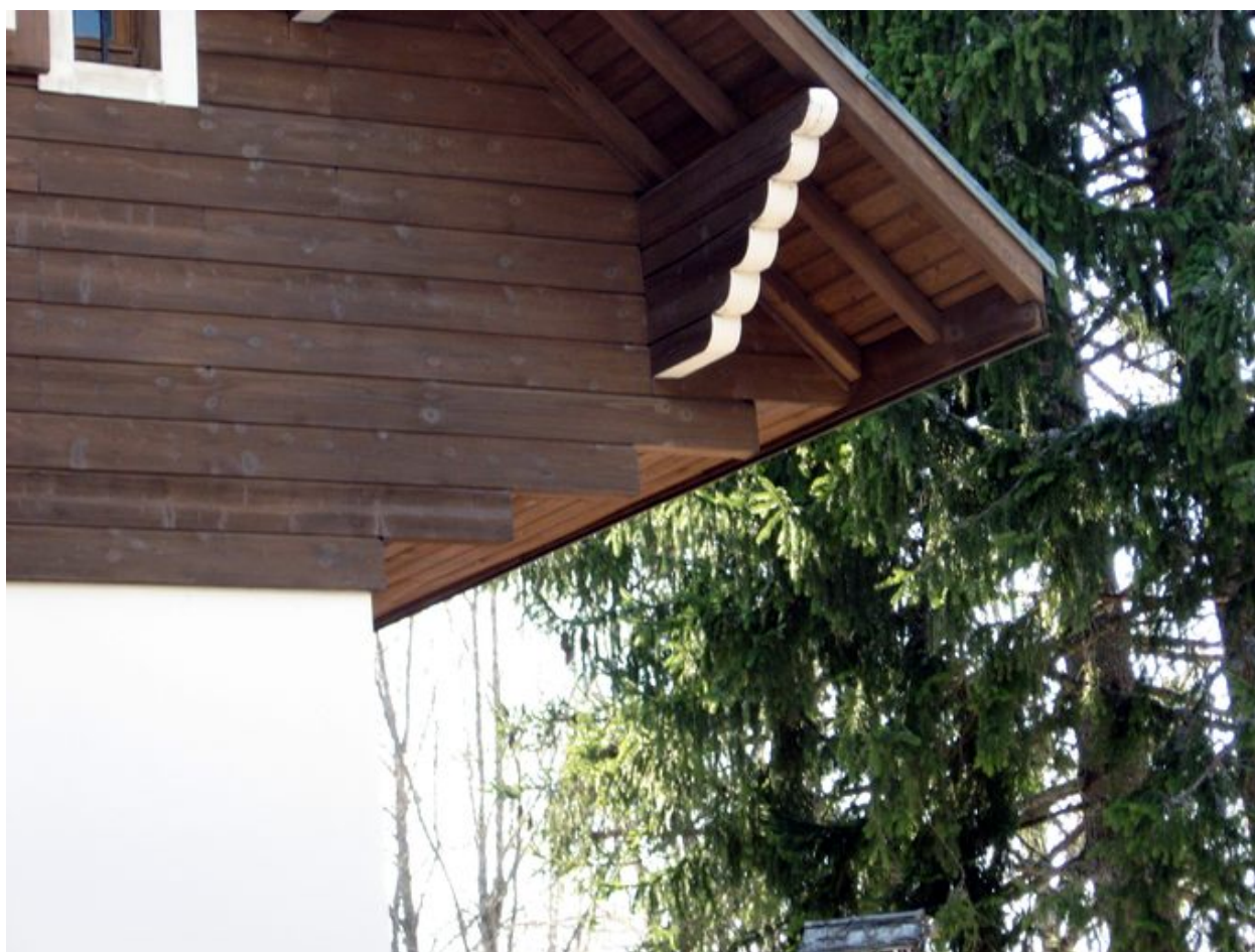
Détail de l'avant-toit
