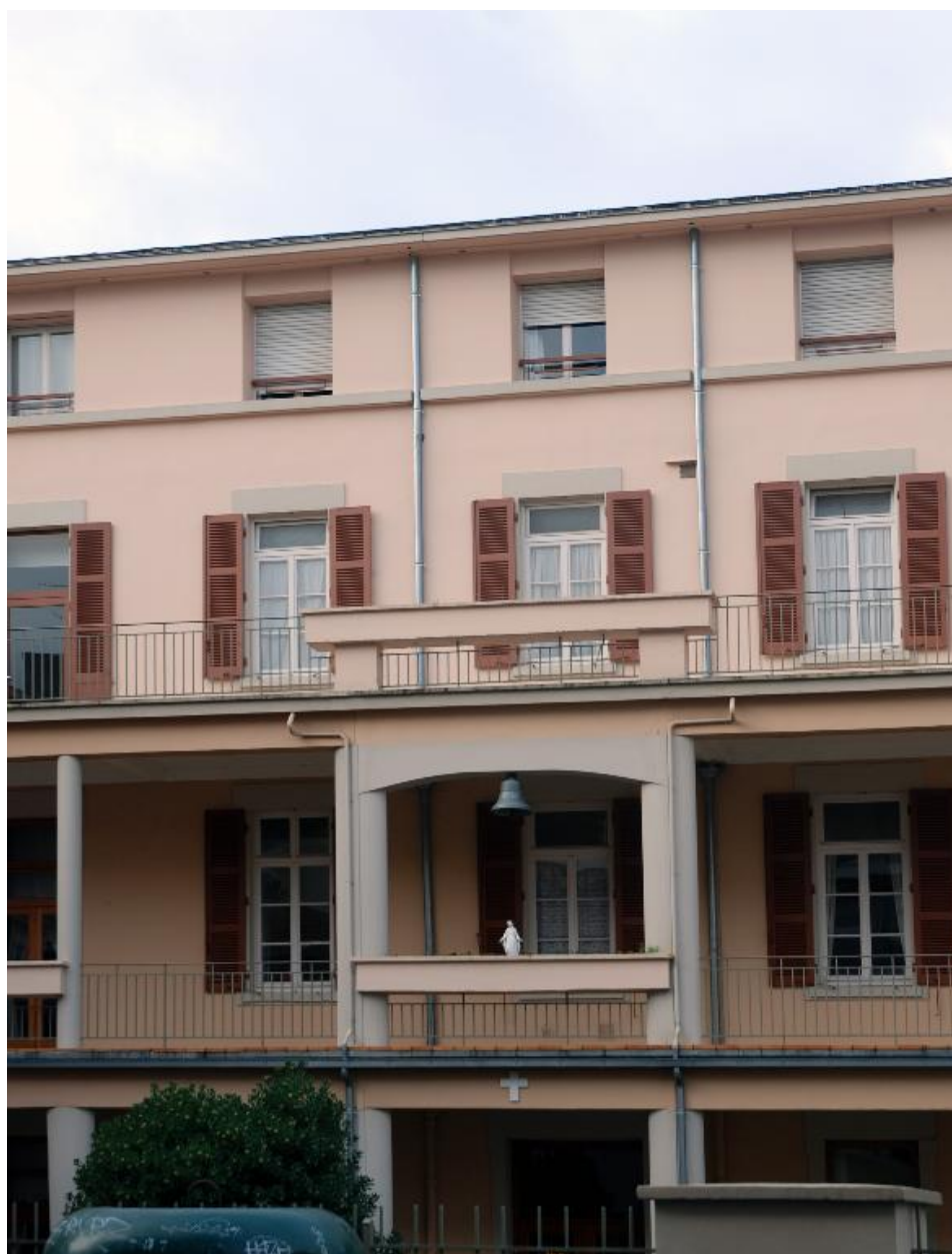
Corps de bâtiment principal : détail de l'élévation
