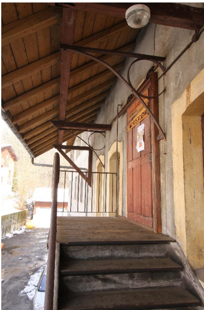
Vue de détail de la coursive animant la façade antérieure au nord ouest du bâtiment de l'usine
