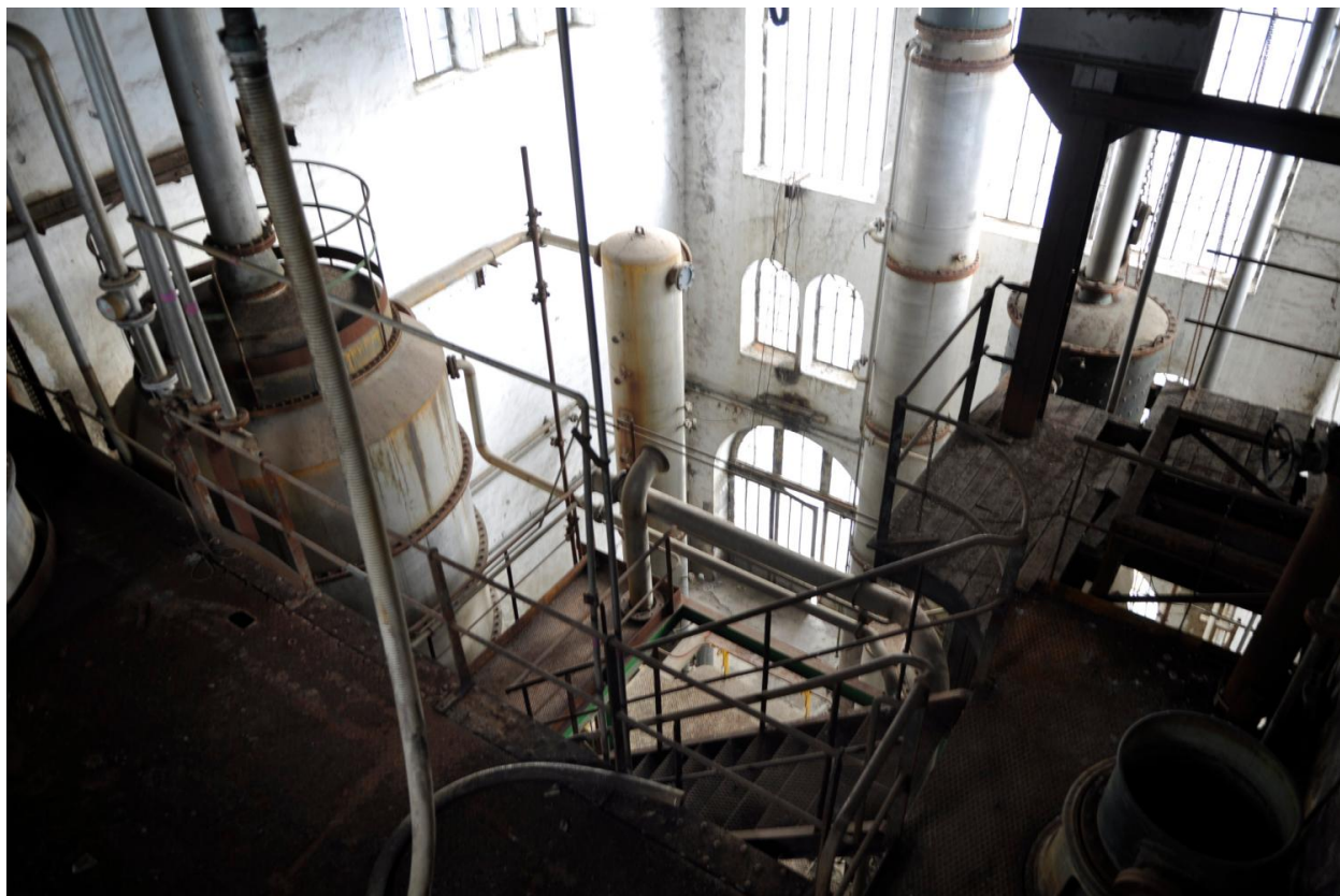
Vue de l'intérieur de la distillerie.
