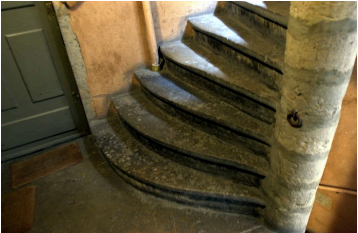
Escalier, palier du 3e étage, détail des marches de la partie ajoutée au 18e siècle
