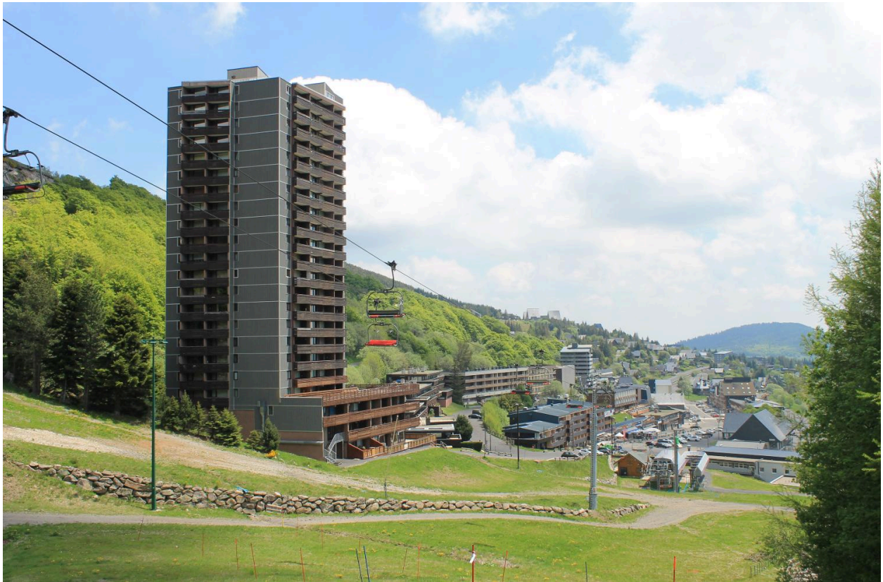
Super-Besse, la Tour de la Biche vue de l'ouest (façade postérieure nord-ouest et façade latérale sud-ouest).
