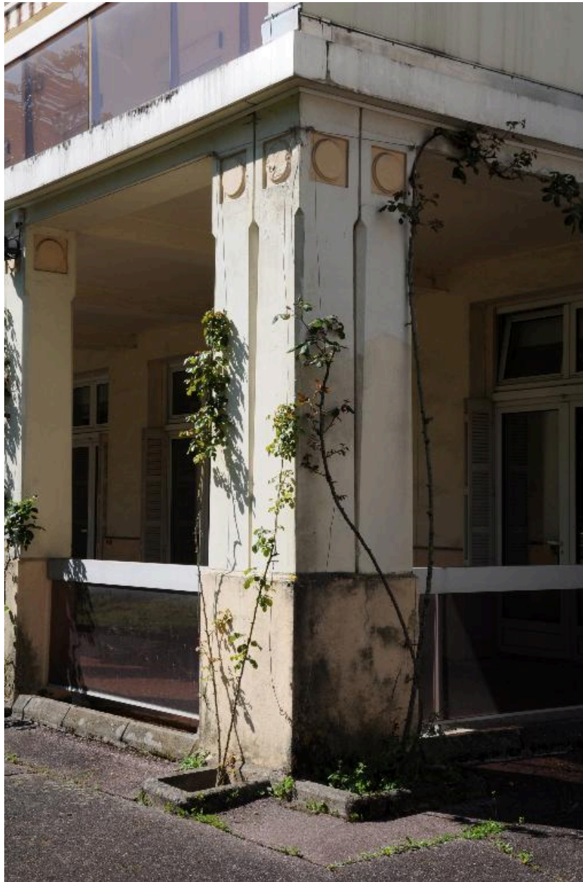
Pilier supportant la terrasse
