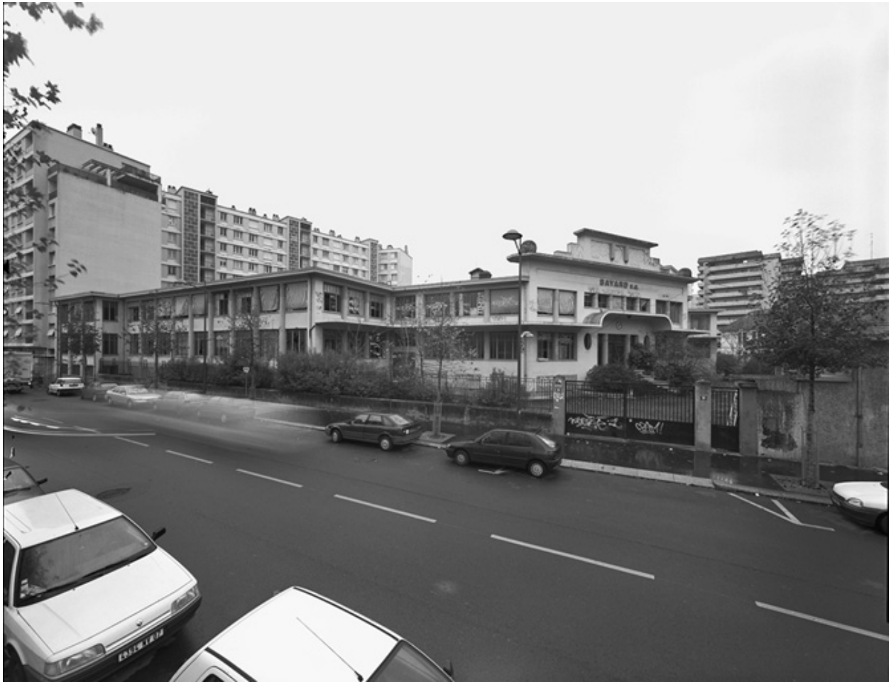
Vue d'ensemble nord-est
