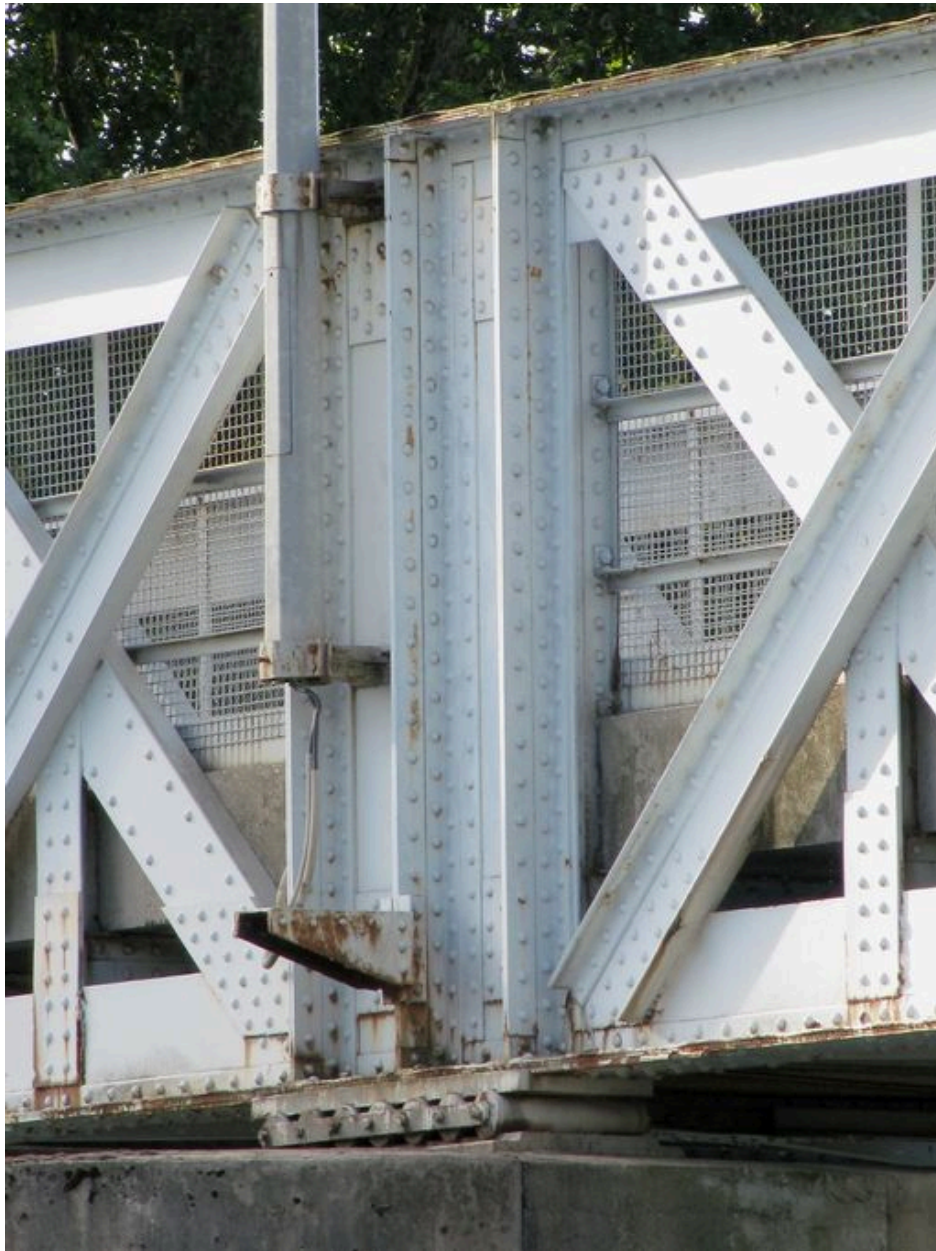
Tablier, face amont, vue de détail : jonction avec la pile (depuis la rive droite)
