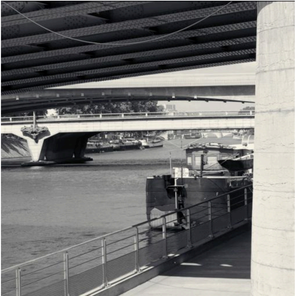
Vue d'ensemble vers le nord depuis le bas-quai, à la hauteur du viaduc de la Quarantaine : l'enfilade des 3 ponts (la Quarantaine, autoroutier et Kitchener-Marchand)
