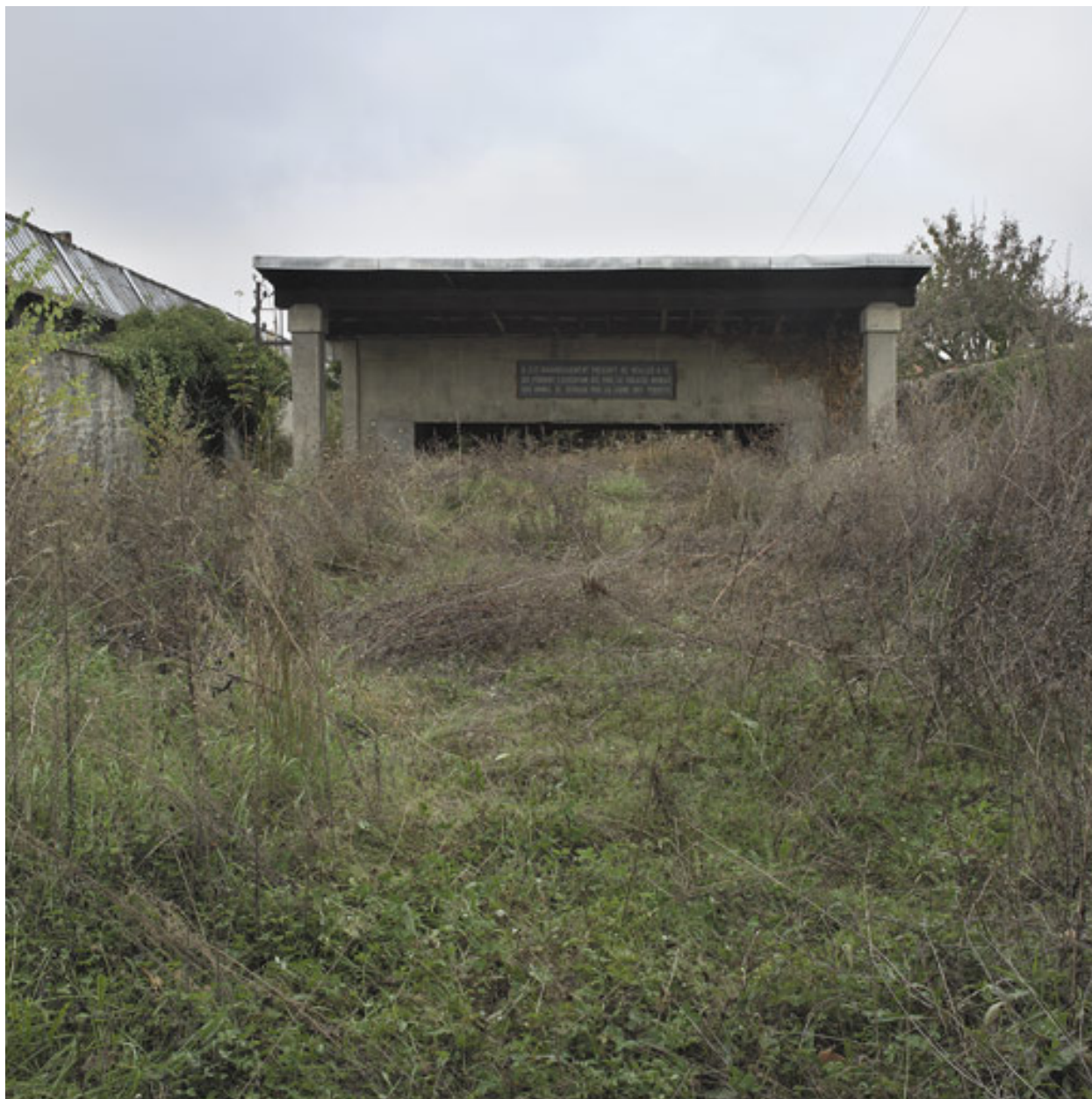
Vue partielle intérieure du stand de tir.
