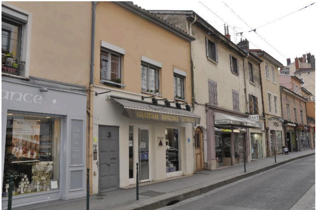
Vue d'ensemble nord ouest de l'immeuble de deux étages
