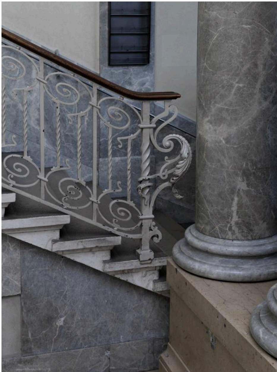
Salle Rameau : escalier A, départ du garde-corps
