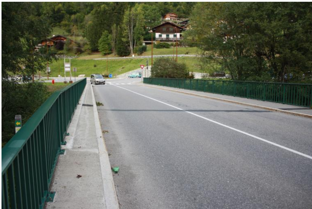
Pont des Plagnettes, Contexte, chaussée et gardes corps
