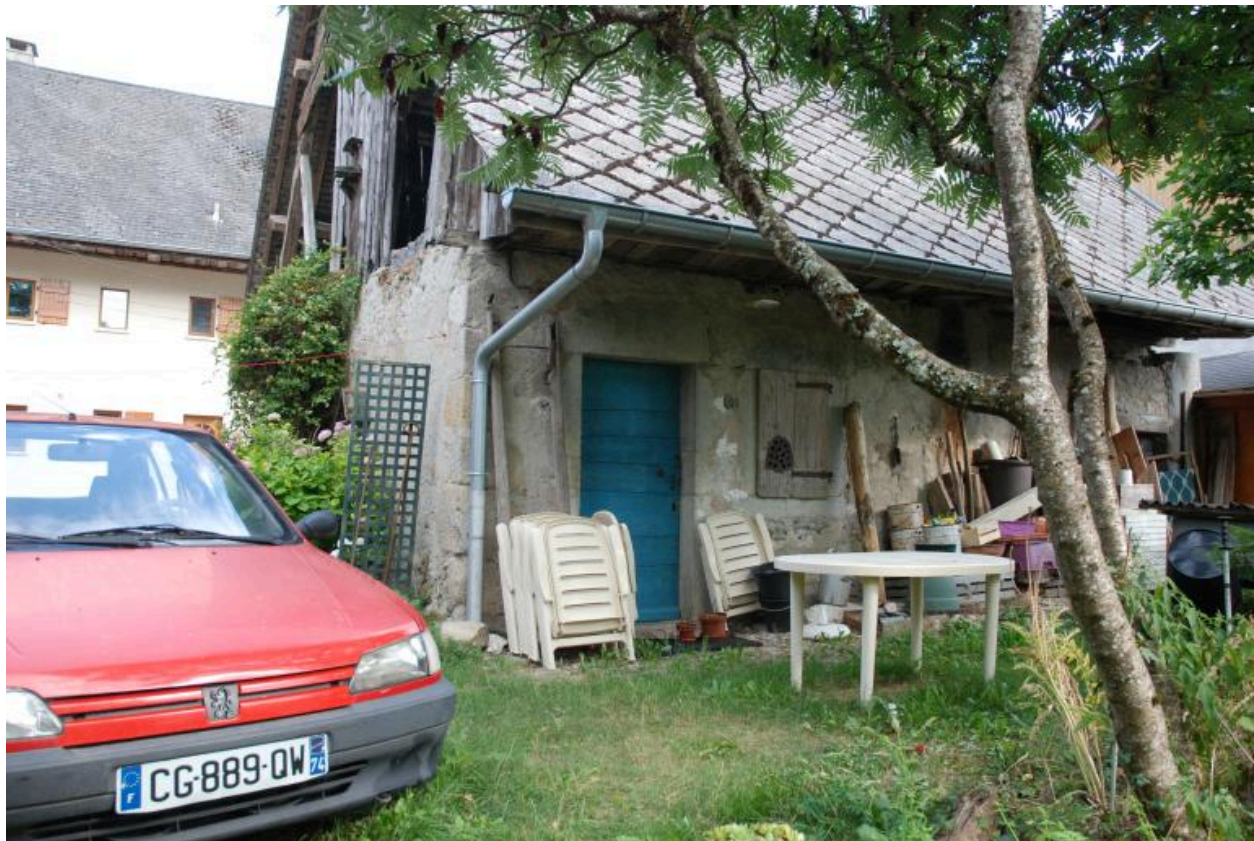
Ferme (2017 C4 352), non repérée. Bâtiment annexe avec chambre et cave.
