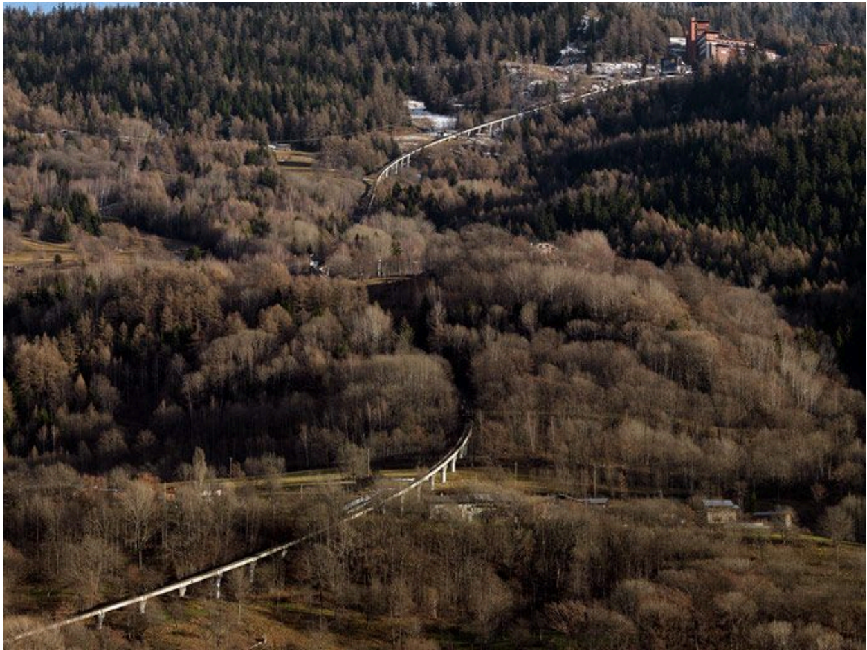
La ligne du funiculaire entre Bourg-Saint-Maurice et Arc 1600
