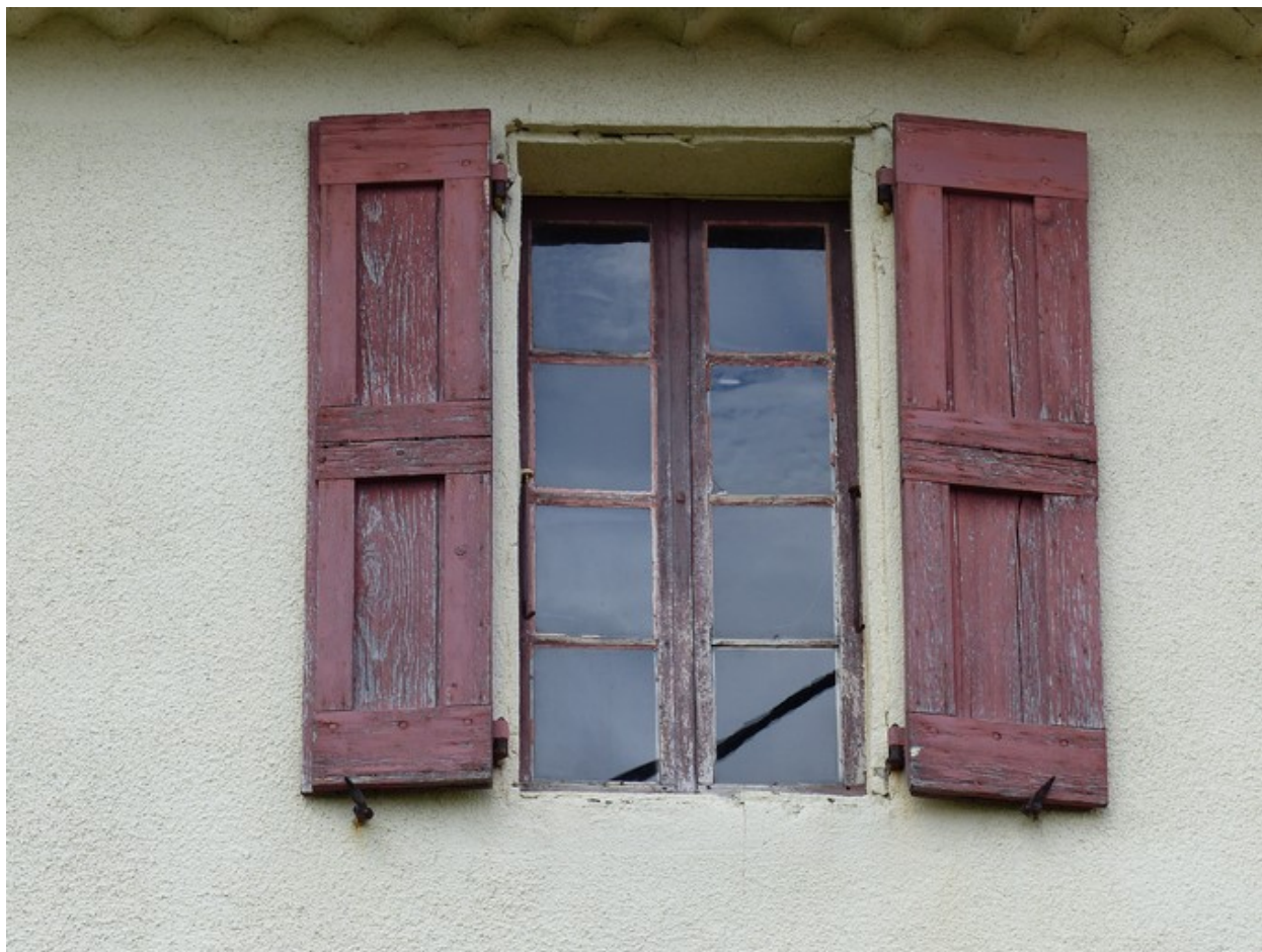
Bâtiment du logis. Elévation ouest, troisième niveau. Fenêtre équipée de contrevents à cadre.
