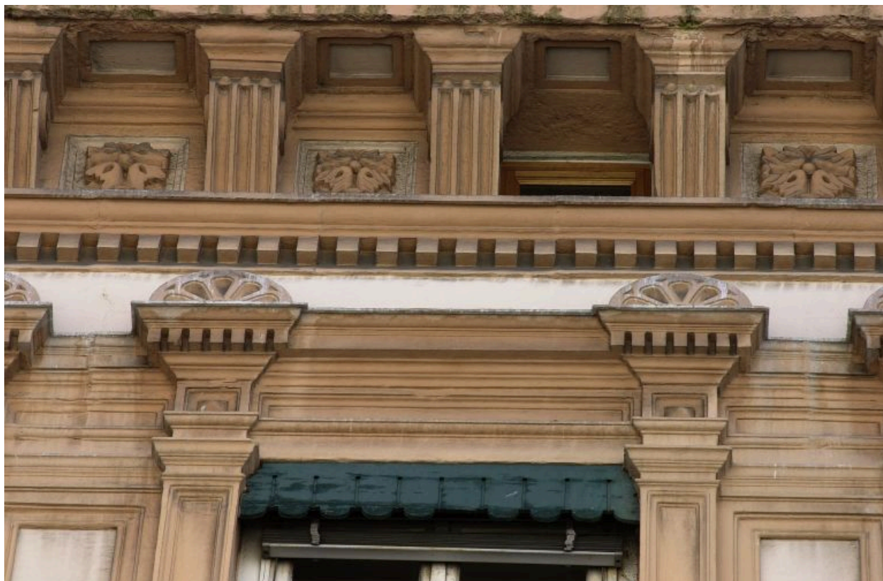
Façade sur la rue des Bouquetiers, 5e niveau, détail de la 8e fenêtre
