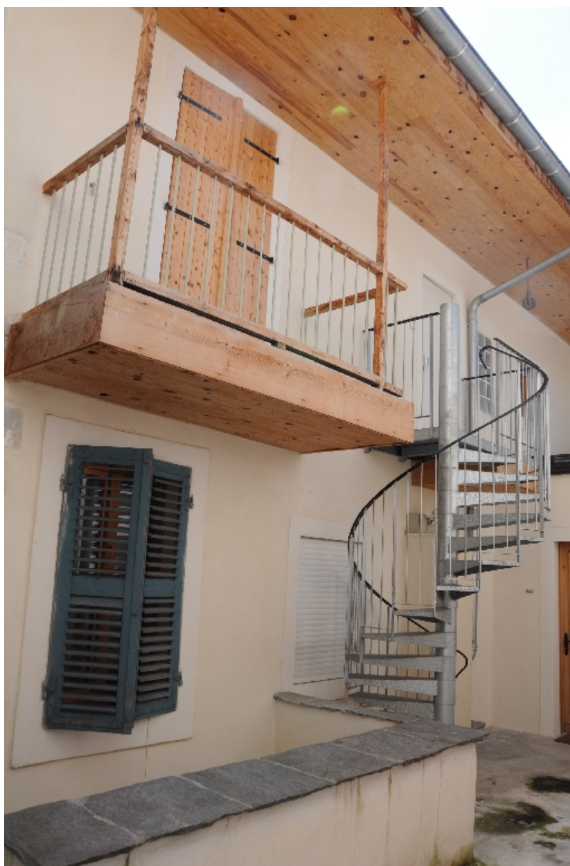
Façade postérieure du corps principal
