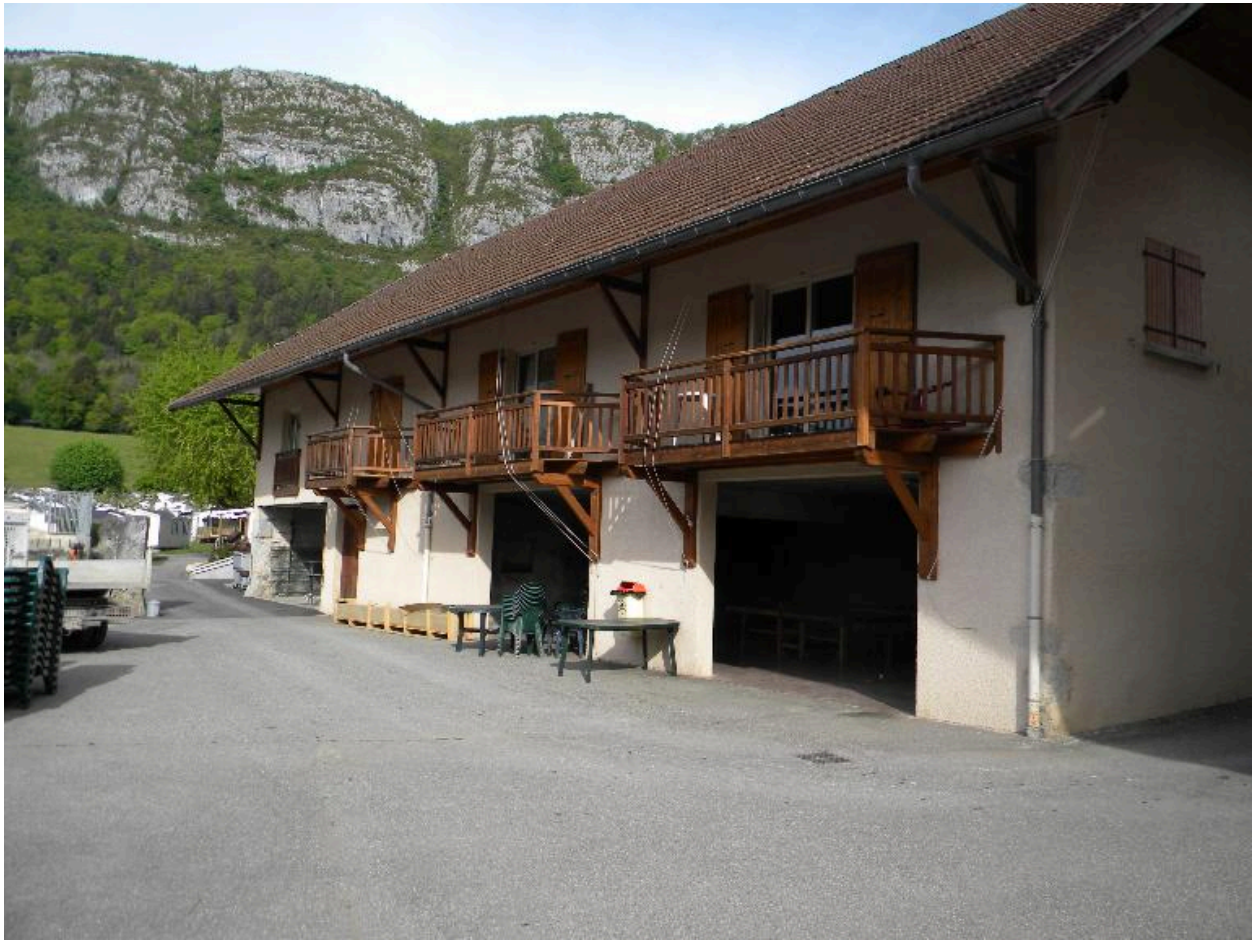
Vue de la façade principale d'une ancienne dépendance.
