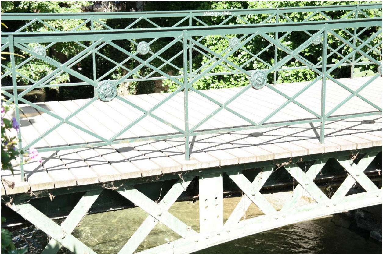
Passerelle de l'Évêché, détail des garde-corps et de la structure métallique
